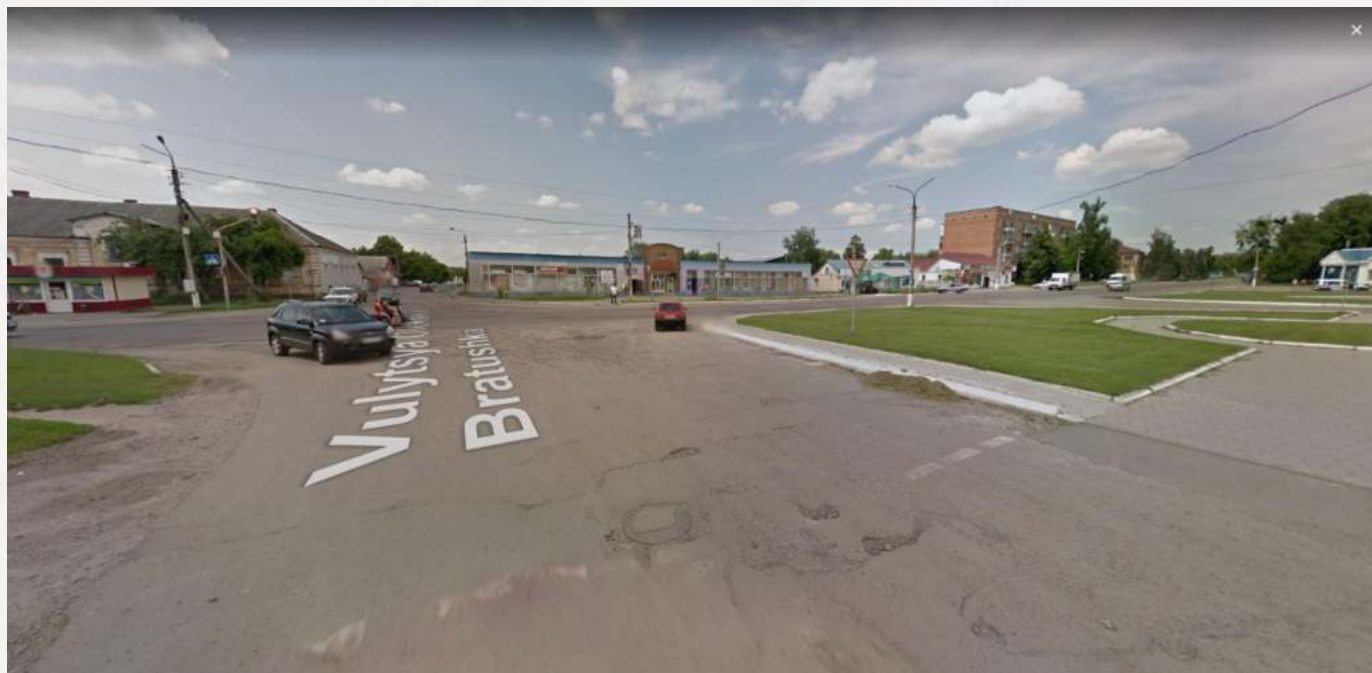
Проблемне перехрестя у Тростянці (Google Street View, 2015)
